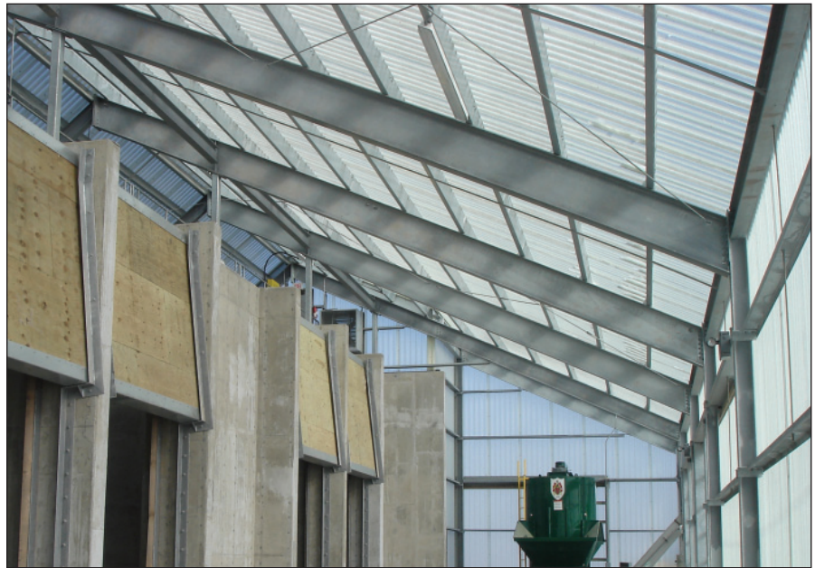
Instalación para almacenaje de fertilizantes con tejado y páneles laterales DuroLite de Enduro
