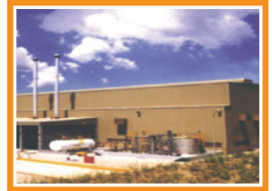
Instalación para almacenaje de fertilizantes con tejado y páneles laterales DuroLite de Enduro
